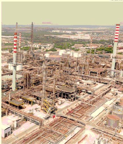
Complesso industriale. Una veduta del sito produttivo ex Ilva di Taranto
